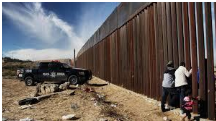
Muro en construcción
